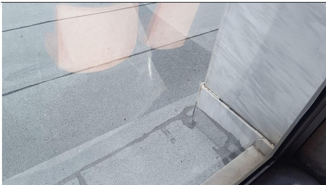
Εικ. 9: Σημείο εισροής υδάτων από το δώμα του ημιυπαίθριου
