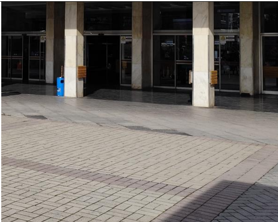
Εικ. 7: Ασυμβατότητα υλικών επίστρωσης. Πηγή: Φωτογραφική αποτύπωση.
